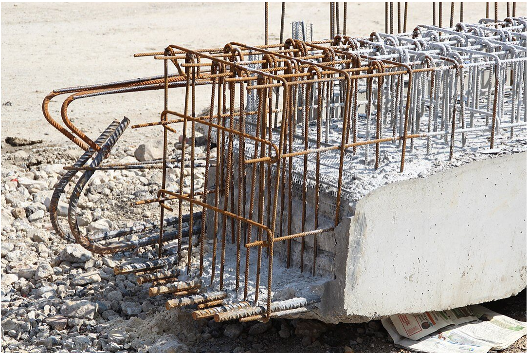
Figura 4.3. Viga de hormigón reforzado, nótese las barras de acero en la zona a compresión ( Lionel Allorge , en Wikimedia, CC BY-SA 3.0).
