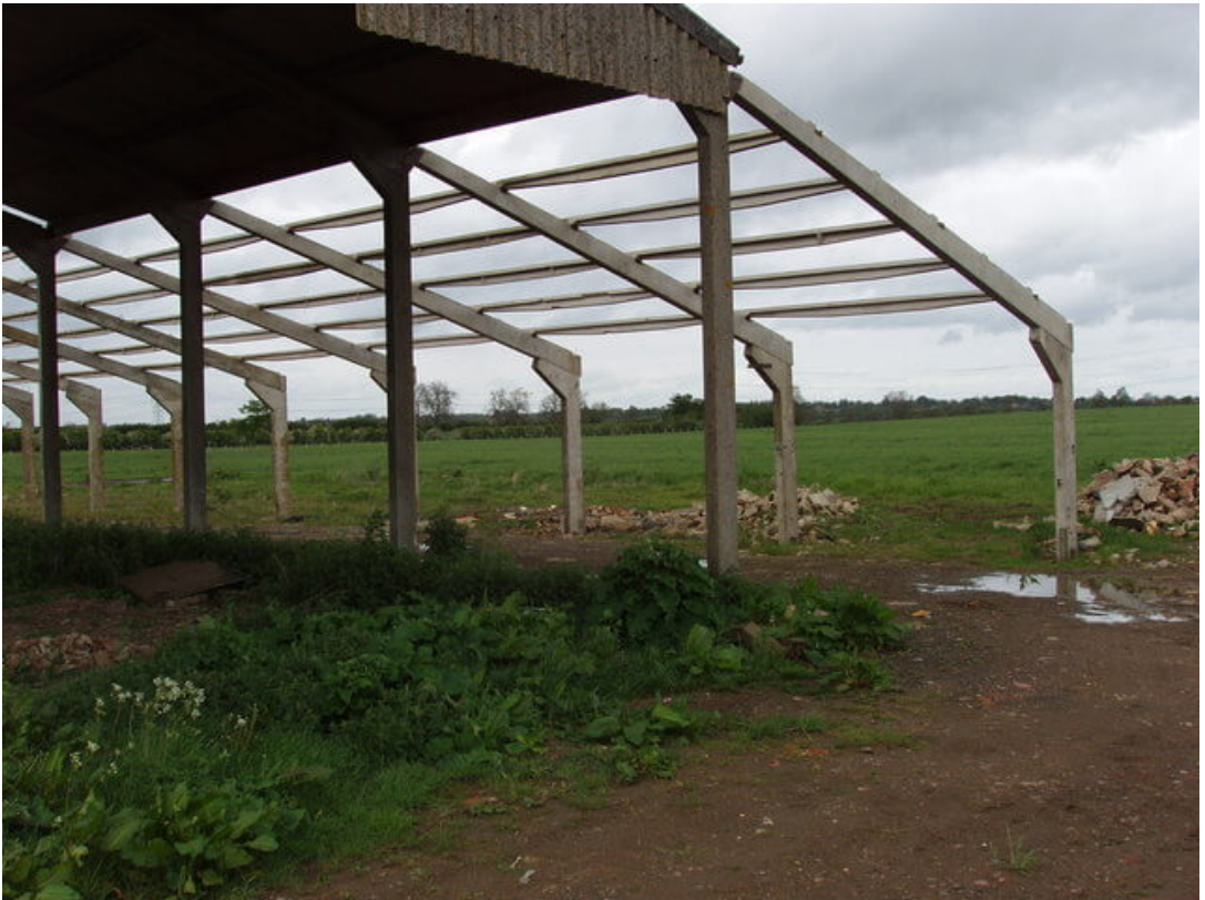
Figura 5.3. Vigas de hormigón para un granero (Foto de David Hawgood , Wikimedia, CC BY-SA 2.0).
