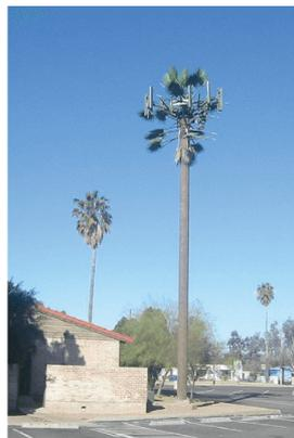
**Figura 6.4.** Las torres de radio y celulares se utilizan normalmente para transmitir radiación electromagnética de longitud de onda larga. Cada vez más, las torres celulares están diseñadas para mezclarse con el paisaje, como con la torre celular de Tucson, Arizona (derecha) disfrazada de una palmera (Crédito extremos: modificación del trabajo por Sir Mildred Pierce; crédito medio: modificación del trabajo por M.O. Stevens).
