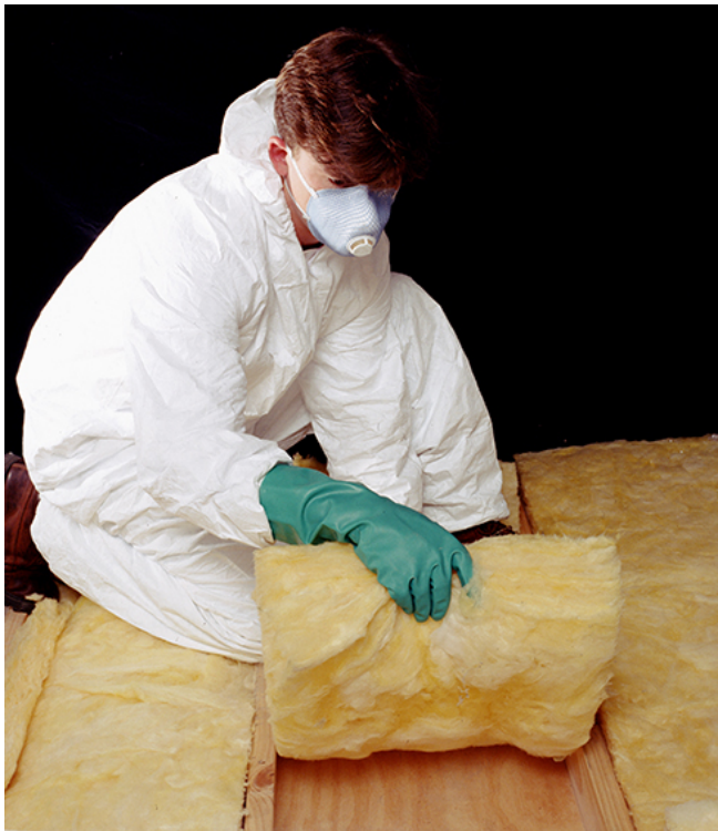
Figura 1.23. La pieza de fibra de vidrio se utiliza para aislar paredes y techos para evitar la transferencia de calor entre el interior del edificio y el entorno exterior. (crédito: Tracey Nicholls)
