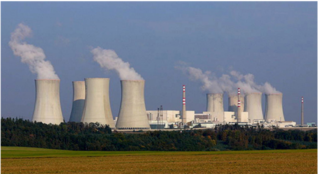
Figura 4.6. El calor que se consume en una planta de energía nuclear va a las torres de refrigeración, donde se libera a la atmósfera.
