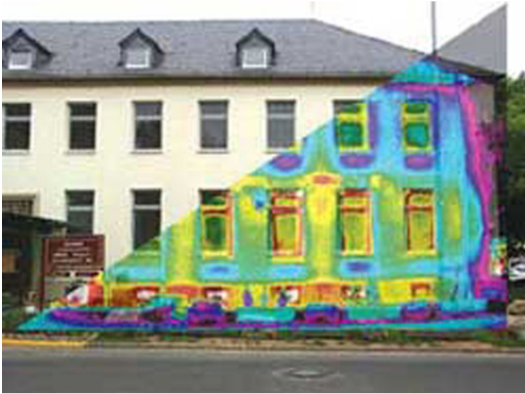
Figura 1.32. Un termógrafo de una parte de un edificio muestra las variaciones de temperatura, lo que indica que la transferencia de calor hacia el exterior es más severa. Las ventanas son una importante región de transferencia de calor hacia el exterior de las casas. (crédito: Ejército de los EE. UU.)
